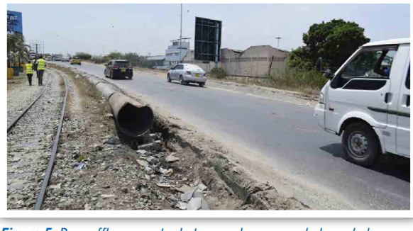
Figure 5: Des affleurements de tuyaux dangereux le long de la chaussée à Makupa. Notez la proximité entre la route et la voie ferrée
