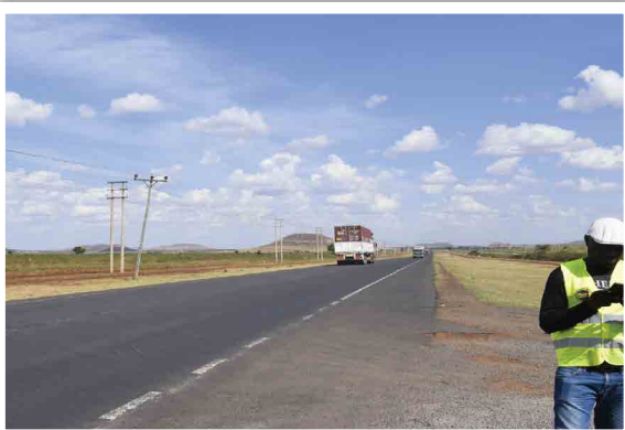
Figure 15: Une longue section droite le long de la zone Pipeline. Des marquages de la route estompés peuvent également être observés
