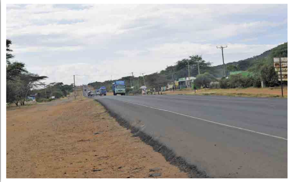
Figure 16: Zone Kalimbini (Une longue section droite avec une légère descente du côté de incitant les automobilistes à la survitesse et au dépassement imprudent)
