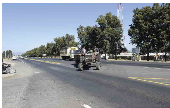
Figure 23: Manque de voie d'accélération pour le trafic à destination d'Eldoret bound en provenance de Njoro
