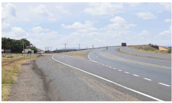
Figure 13: Configuration dangereuse à la jonction Emali/Oloitoktok
