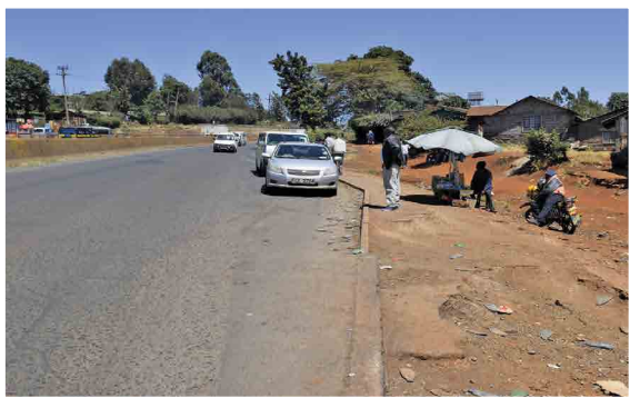
Figure 18: Emplacement dangereux pour l'arrêt bus de Nairobi
