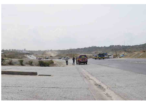
Figure 9: Embarquement/débarquement des passagers à des endroits non désignés (les parkings des bus n'ont pas été prévus)
