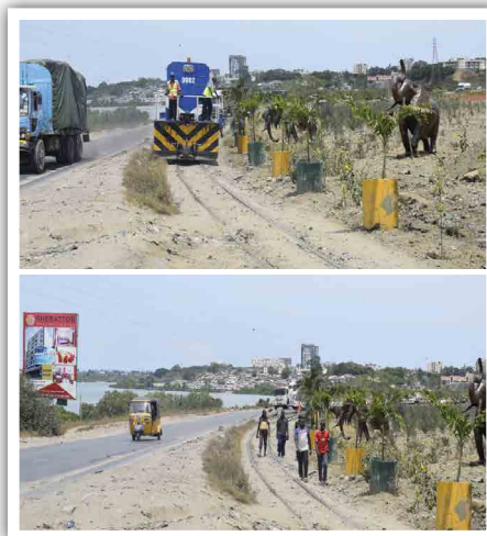
Figure 6: Absence de barrière entre la route et la ligne de chemin de fer, ce qui devient un risque de sécurité pour les piétons
