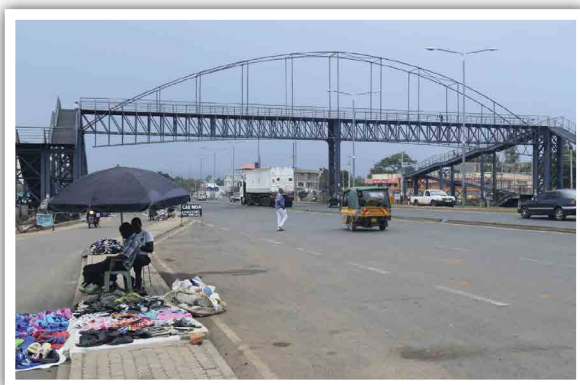
Figure 32: Piéton traversant dangereusement l'autoroute à un passage à niveau malgré l'existence d'une passerelle piétonnière
