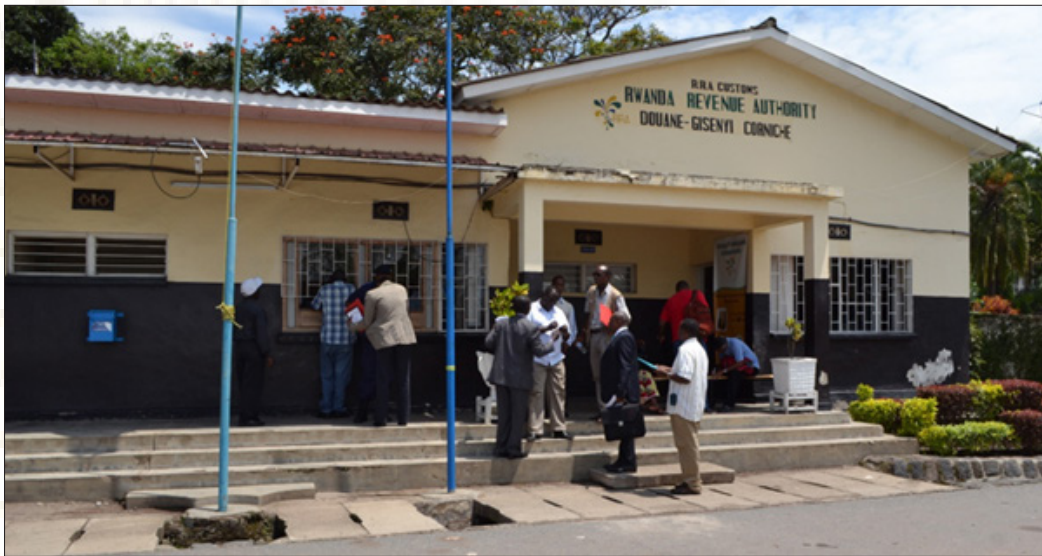
Ci-dessus: En mars 2013 ; au Bureaux du poste frontalier de La Corniche à Rubavu.
