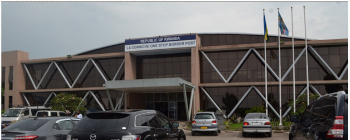
Ci-dessous: en décembre 2019 bureaux du PFAU la Corniche à Rubavu - poste frontière entre le Rwanda et la RDC
