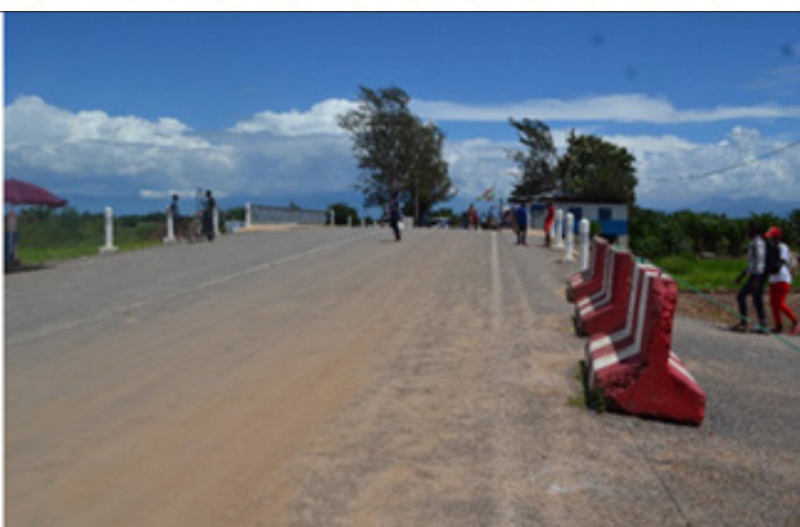
Photo à droite: décembre 2019, la capacité du pont a été améliorée pour transporter des charges plus lourdes avec deux voies pour la circulation motorisée et des voies piétonnes de chaque côté.
