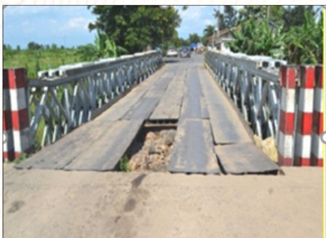
Photo à gauche: En mars 2013, le pont à une voie sans passerelle pour piétons au poste frontière de Gatumba / Kavimvira entre le Burundi et la RDC avait besoin d'être réparé, l'équipe d'enquête de l'ACTTCN
